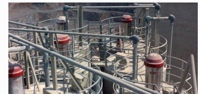
Аспирация силоса с использованием PNEUFIX и FLOW-BOW®
